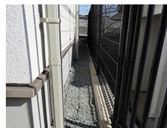
9 10 境界はなれ50cm以上 建物周囲の砂利敷き 隣地との境界線と建物外壁までは50cm 以上としています。また建物周りには通ると 音がする砂利を敷き不審者の侵入を抑止 しています。
