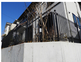
5 落下防止フェンス 高低差のある擁壁にはフェンスを設置して います。擁壁の高さによりフェンスの高さも 変え、安全に配慮しています。
