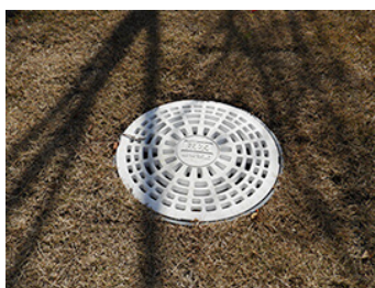
8 集水桝 大雨や雪が積もった時でも庭に水がたまら ないよう集水桝を設置しています。
