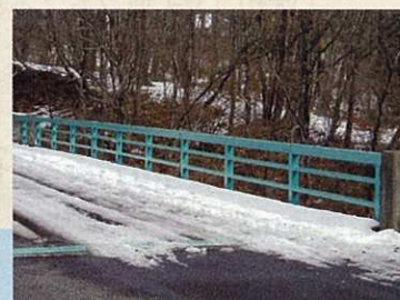
橋梁塗装工事
