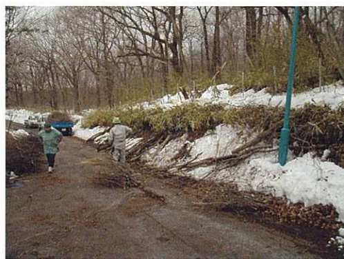
御料地沿い樹木枝下し作業風景
