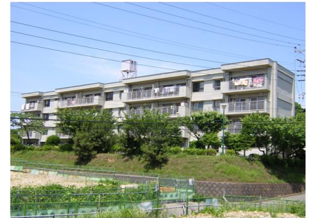
建替え前の外観
